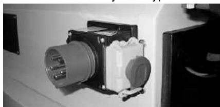
montáž krytu el. vypínače
